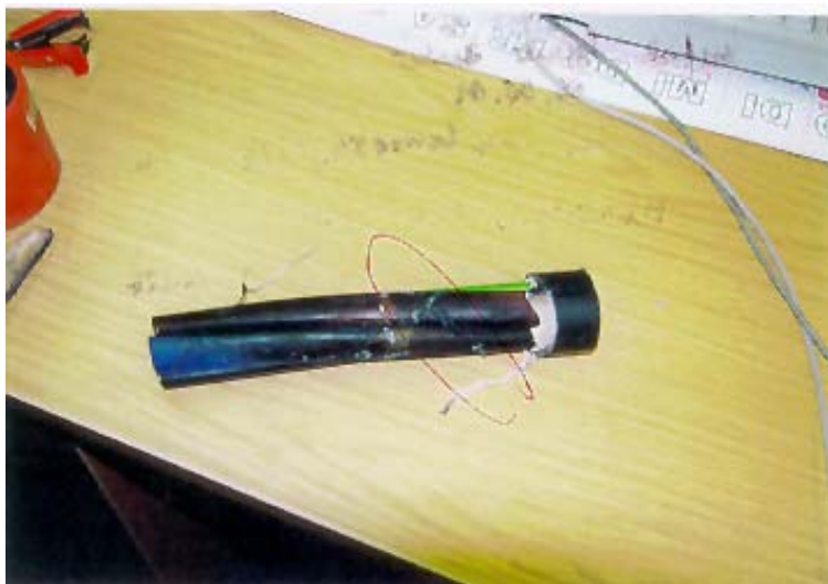
Bild: Beschädigtes Kabelstück, das den Lichtbogen verursachte.
